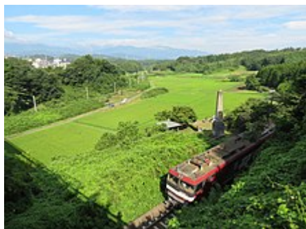
現場付近の様子（2019年8月）
